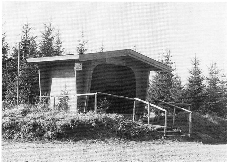
Die Schutzhütte am „Schweinekopf“ in unmittelbarer Nähe der Fulge.
